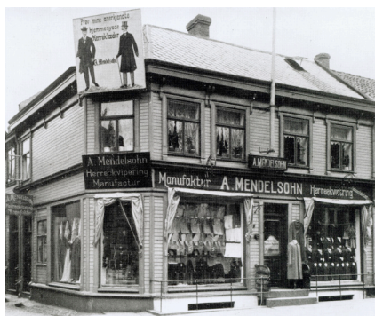
Aron Mendelsohns forretning i Brattørgata 12b (Kilde: NTNU Universitetsbiblioteket)
